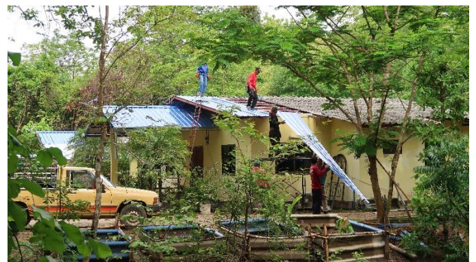
同工宿舍屋頂維修工程已完成
