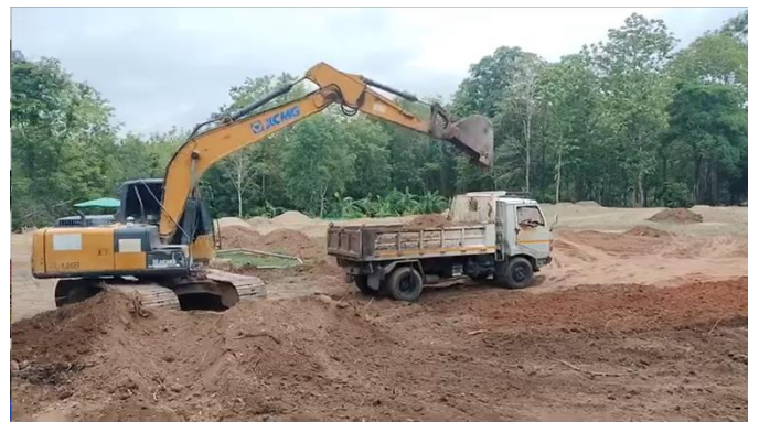
足球場維修工程正在進行中
