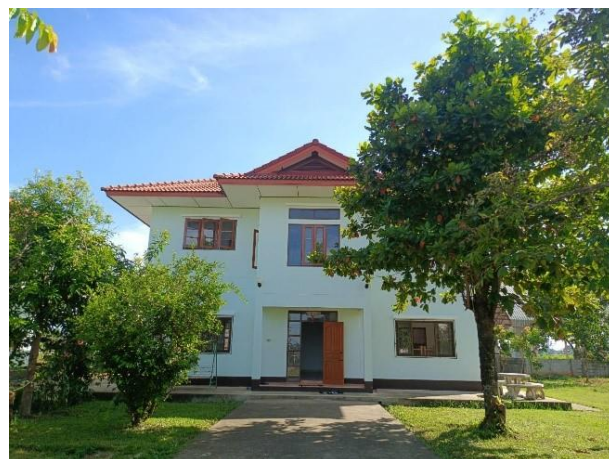
已完成維修的宿舍
