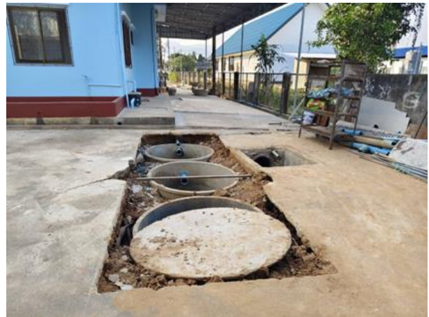
維修化糞系統及污水渠
