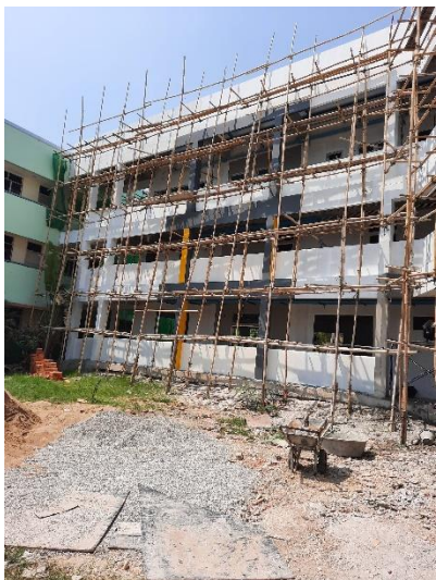
期望五月底完成 A 座大樓的室內工程
