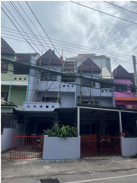
正在裝修中的女生宿舍 是兩座樓房
